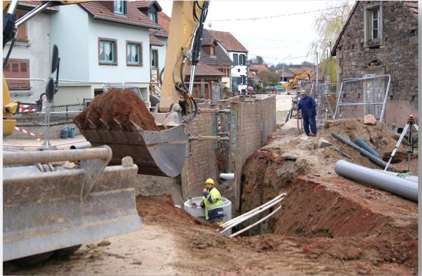
Dans le cadre de ces travaux sur le réseau d'eau potable, la commune a fait poser 9 nouveaux poteaux d'incendie de diamètre 100 mm, 3 dans la rue de Lohr, 4 dans la rue Principale et 2 au lotissement Pochum pour un coût de 28 000 € HT. Avec la pose de ces 9 poteaux d'incendie, le réseau de défense incendie du village est conforme au nouveau règlement départemental.
