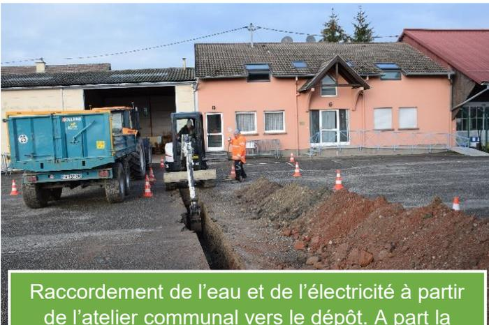
Raccordement de l'eau et de l'électricité à partir de l'atelier communal vers le dépôt. A part la tranchée, ces travaux ont entièrement été réalisés par les élus. A également été changé une des portes sectionnelles du dépôt.
