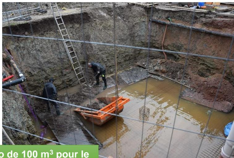
Préparation d'un silo de 100 m<sup>3</sup> pour le stockage des plaquettes de bois
